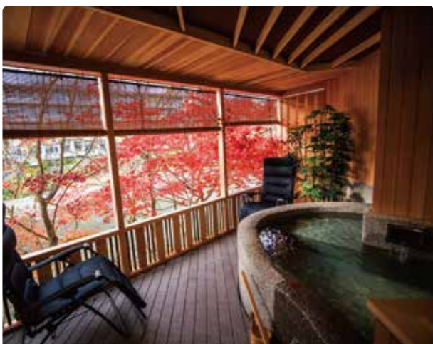
自然対流式熱交換器内蔵浴槽が導入された風呂
