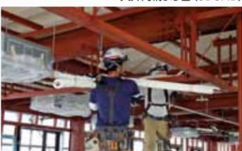
工場プレハブ支持金物への配管施工
