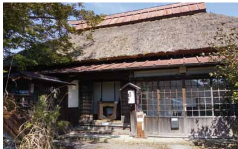
関所の建物。内部が資料館になっている。
