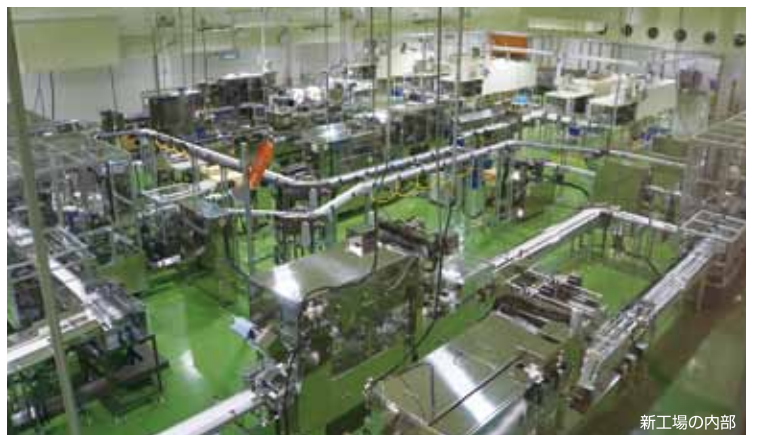
新工場の内部
