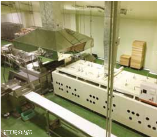
新工場の内部
