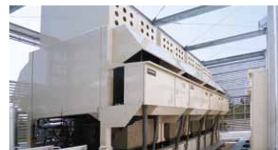
空冷ヒートポンプチャラー
