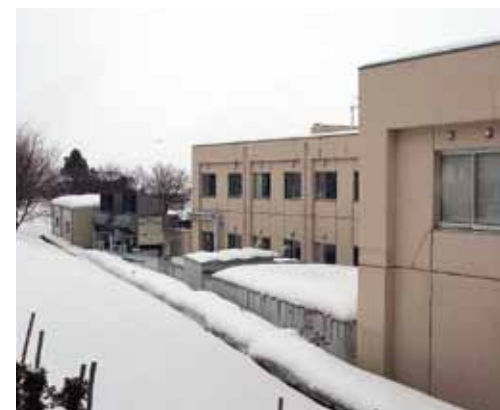
中央の建物が蓄熱槽
