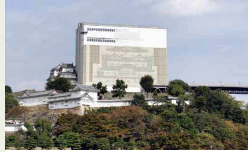
大天守は「素屋根」と呼ばれる囲いですっぽりと覆われています。素屋根の内部に見学用のエレベーターや資材運搬用の搬入路があります。
