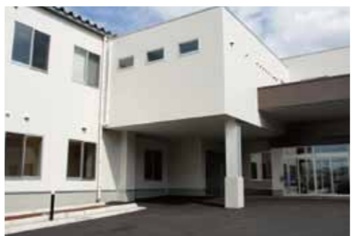
メディカルフィットネス ロコパークのエントランス
