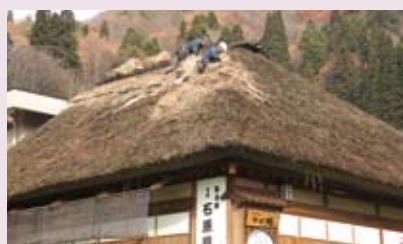
定期的に屋根が葺き替えられている。
