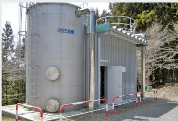
洗浄水保有型ろ過装置
