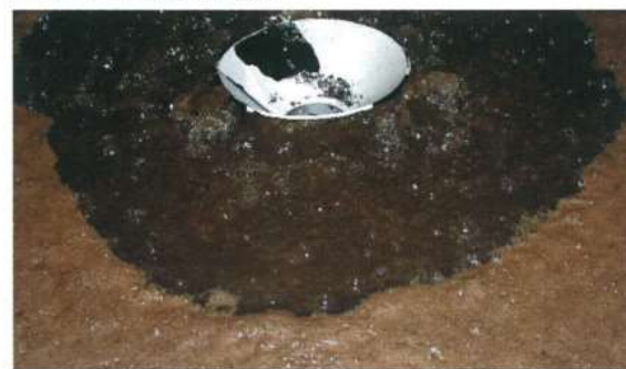
ろ材の空気洗浄状況
