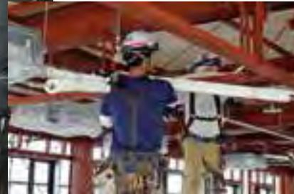
工場プレハブ支持金物への配管施工
