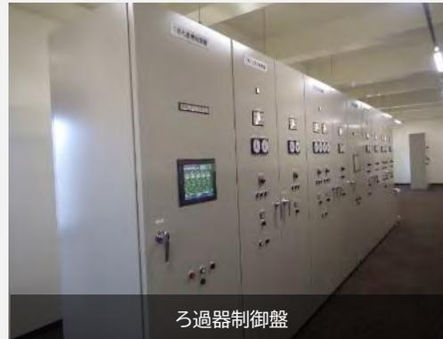
ろ過機10基に対して、ろ過ポンプ5台での運用となるので、ろ過機運転台数により、ろ過ポンプ台数制御およびろ過流量により、インバータを使用してろ過ポンプの回転数制御を実施しています。
