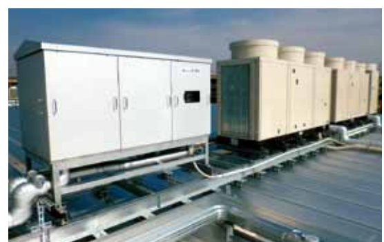
左：排熱回収ユニット 右：排熱回収冷凍機
